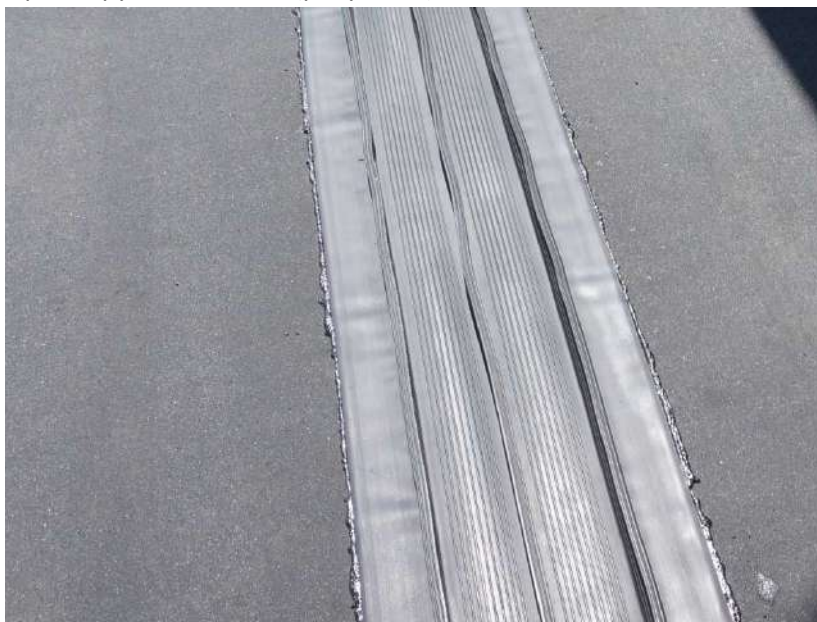
Рисунок 1 – Соединение Гидрошпонки ИКОПАЛ ХН-Б 200/25 с УЛЬТРАНАП
